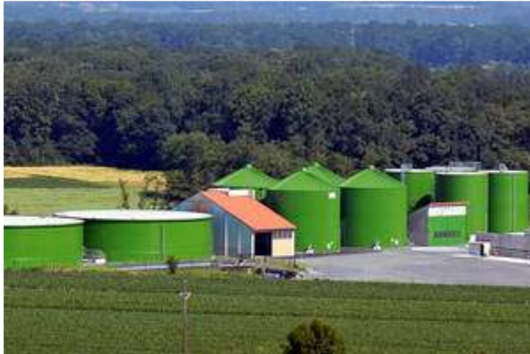
Photo 2: Installation au biogaz de plus grande envergure avec plusieurs digesteurs infiniment mélangé – LIPP (A)
