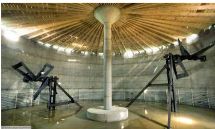
Photo 4: réacteur continu infiniment mélangé - intérieur d'une fosse/digesteur pour effluents d'élevage – Schmack (A)
