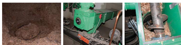
Figure 2 : vue de la vis dans le silo Figure 3 : vue de la vis dans la chaudière Figure 4 : vue intérieure de la vis
