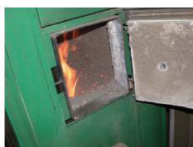
Figure 7 : vue intérieure du four
