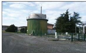
Digesteur (photo : P. Bioulac)
